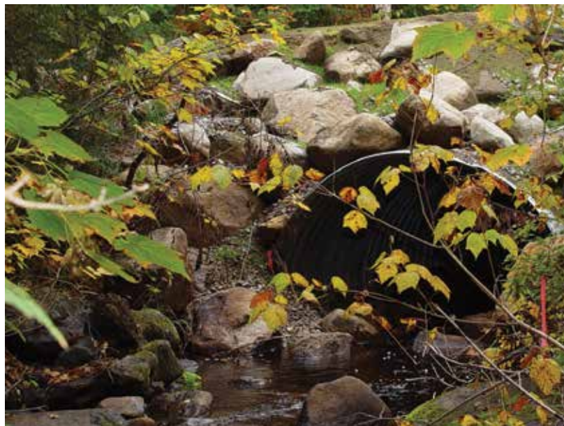
Figure 5.17 Ponceau en arche
