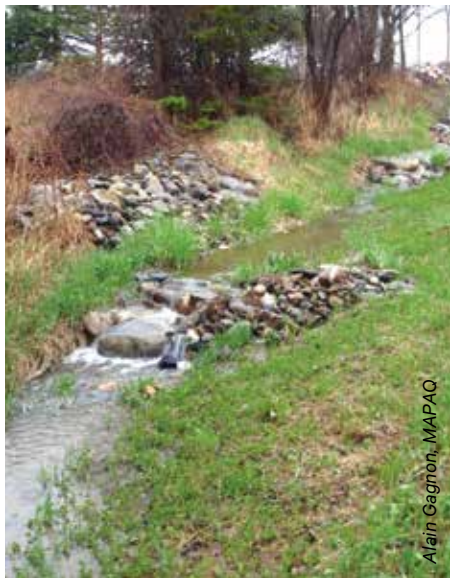
Figure 5.14 Fossé avec seuils de rétention -
