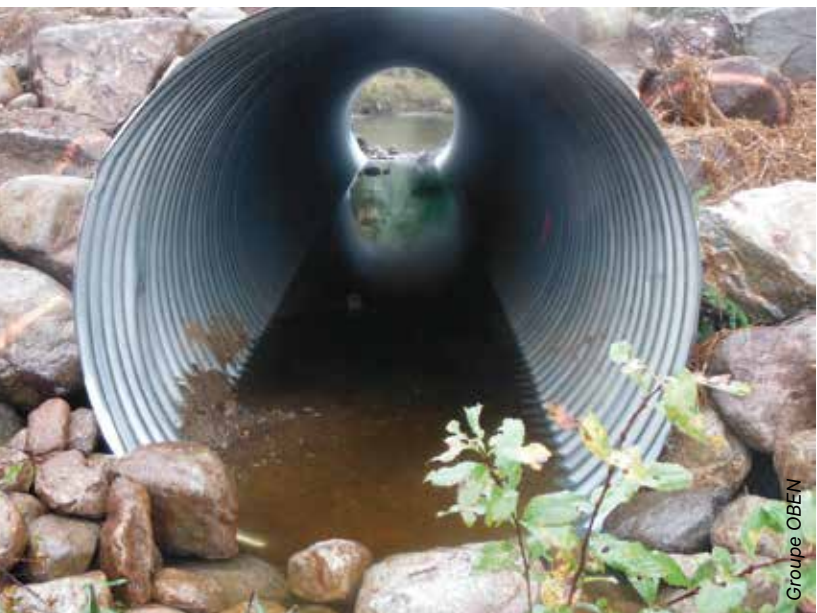
Figure 5.15 Ponceau circulaire avec substrat
