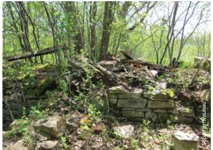
Figure 4.4 Fondations en ruine
