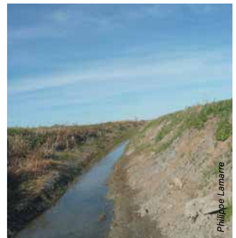
Figure 5.12 Fossé à nu
